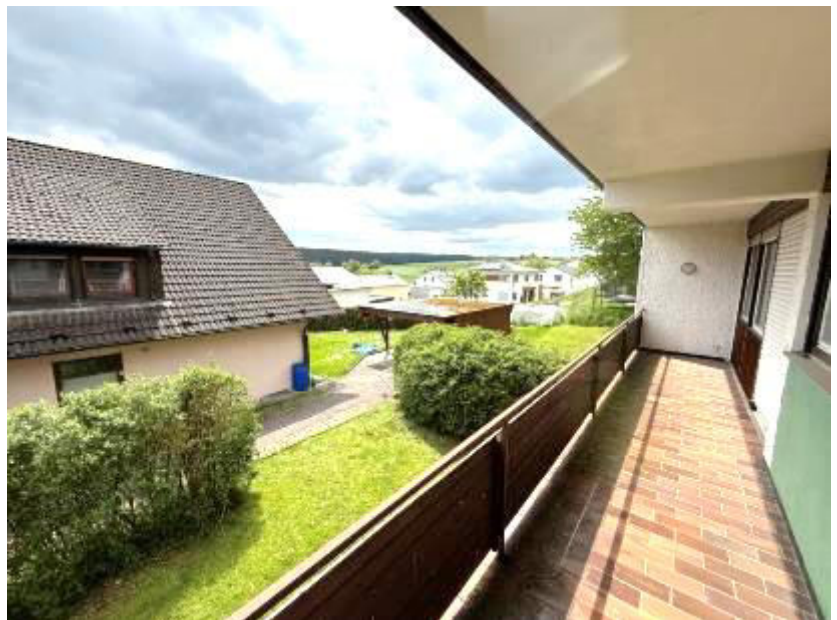
Foto 8 des SV: Wohnung EG; Balkon/Loggia
