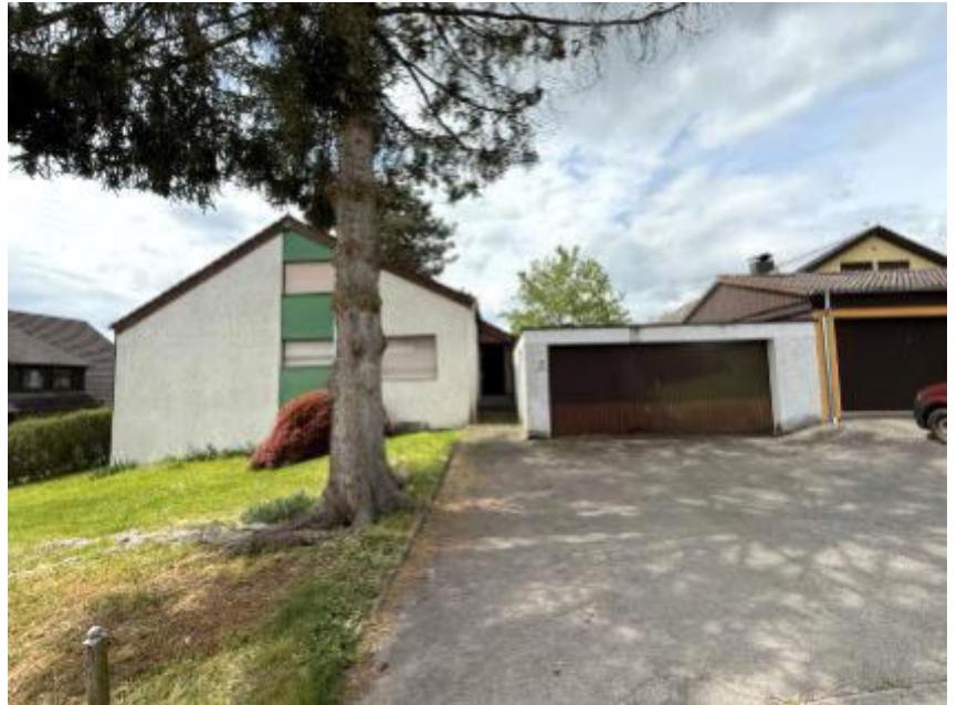
Foto 1 des SV: Ansicht von Osten, Eingangsseite, Straßenansicht
