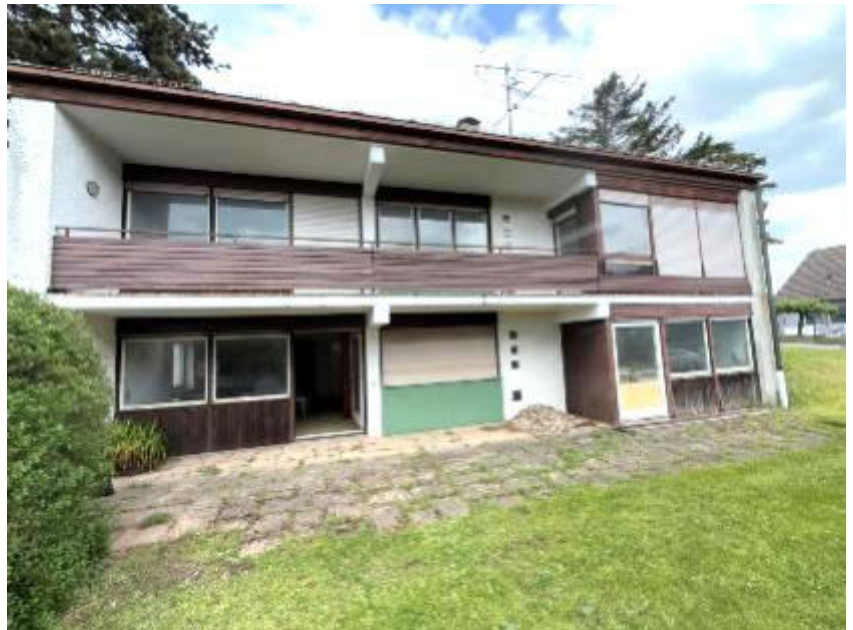
Foto 3 des SV: Ansicht von Süden, Gebäuderückseite
